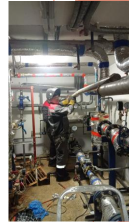
Ремонт системы водоснабжения
