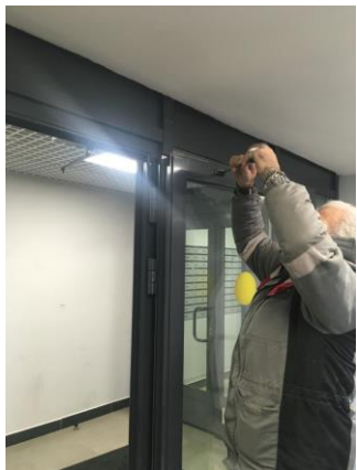
Регулировка доводчика
